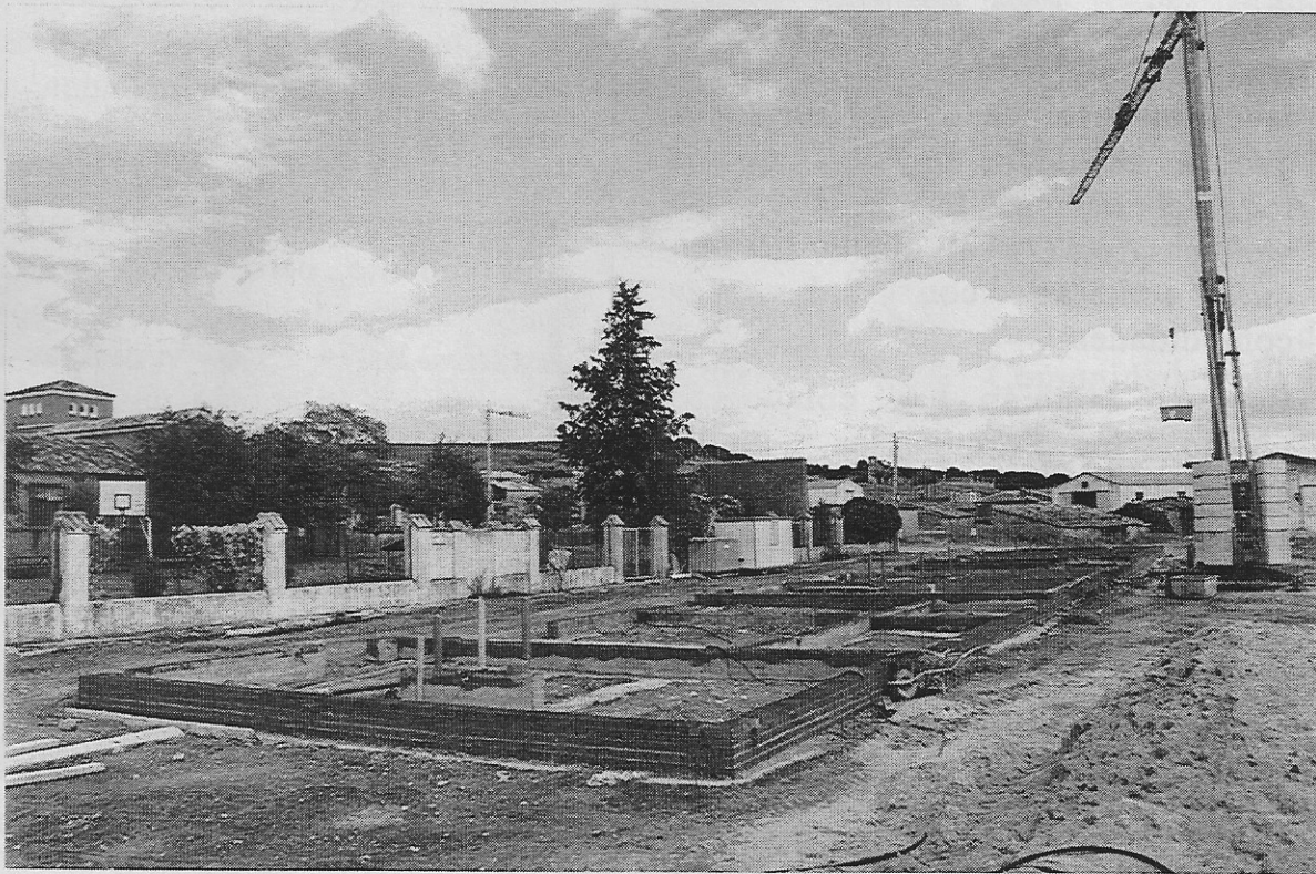
Vista de las obras de la Cooperativa de Viviendas
